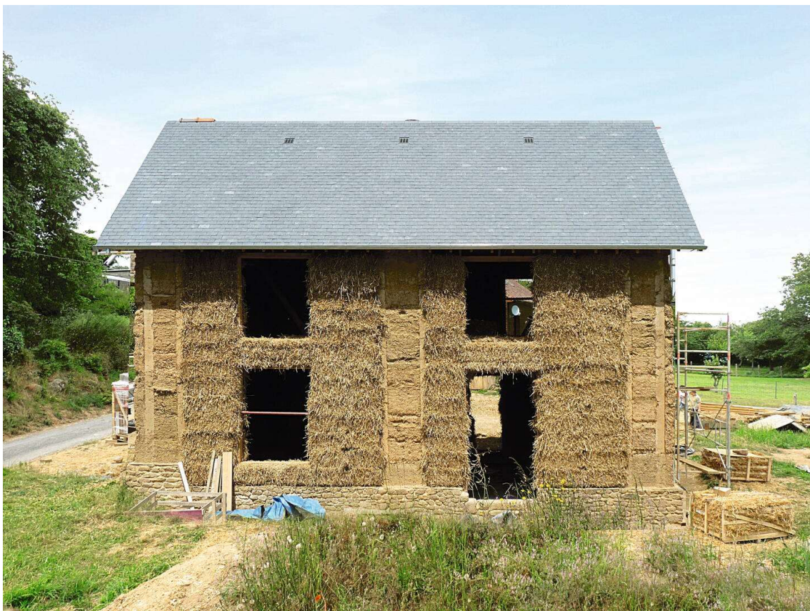
Maison en terre, paille et bois, réalisée en autoconstruction par Anne Lequertier et Simon Martin, ingénieurs en bâtiment (société les Guêpes maçonnes), en 2013. (Anatomies d'Architecture)
